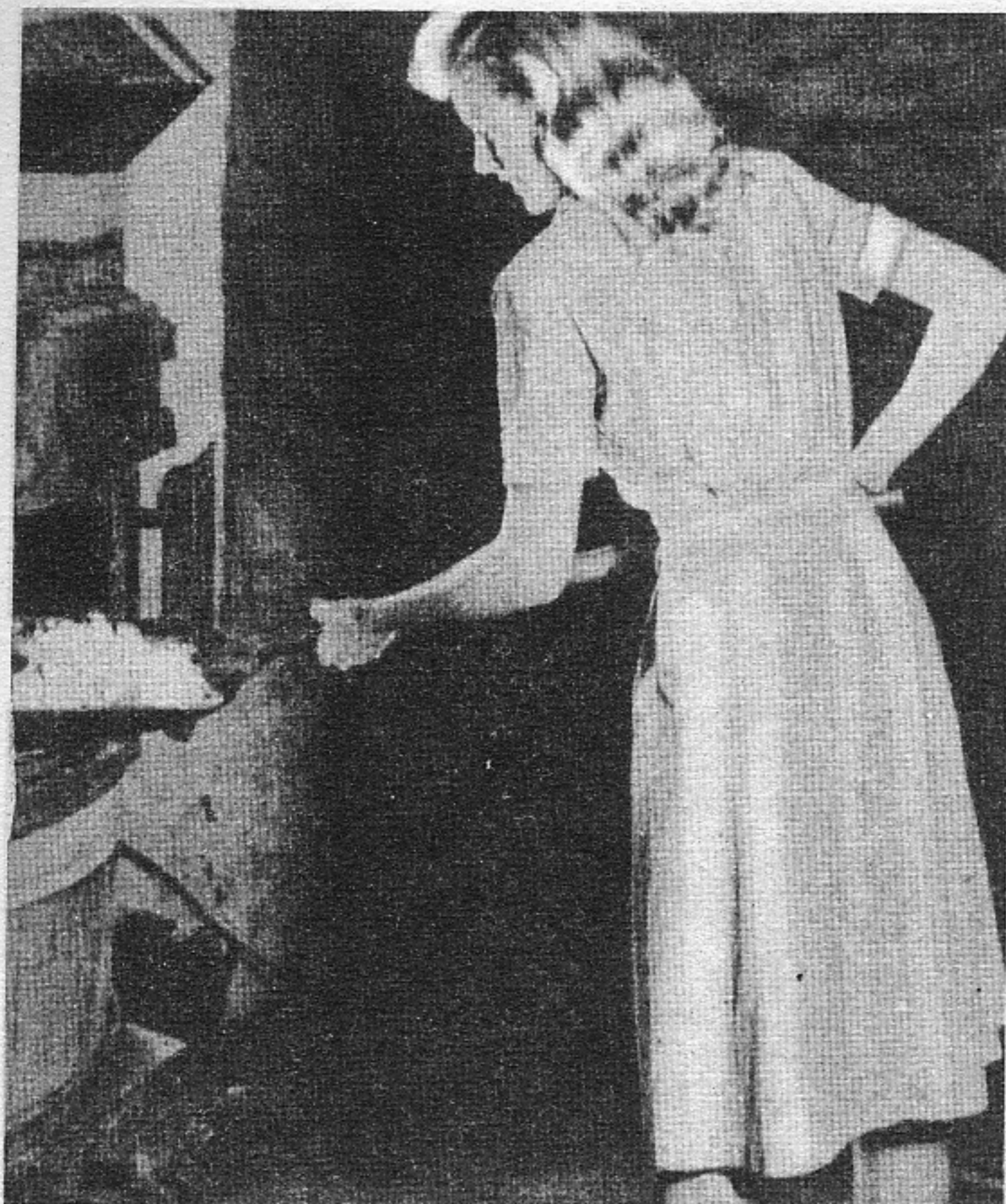
In quattro foto, il sistema corretto per avviare una stufa o una caldaia a carbone od a legna: Prima operazione, distendere uno strato di cenere dello spessore di una cinquantina di mm. sull'intera superficie della griglia del focolare
